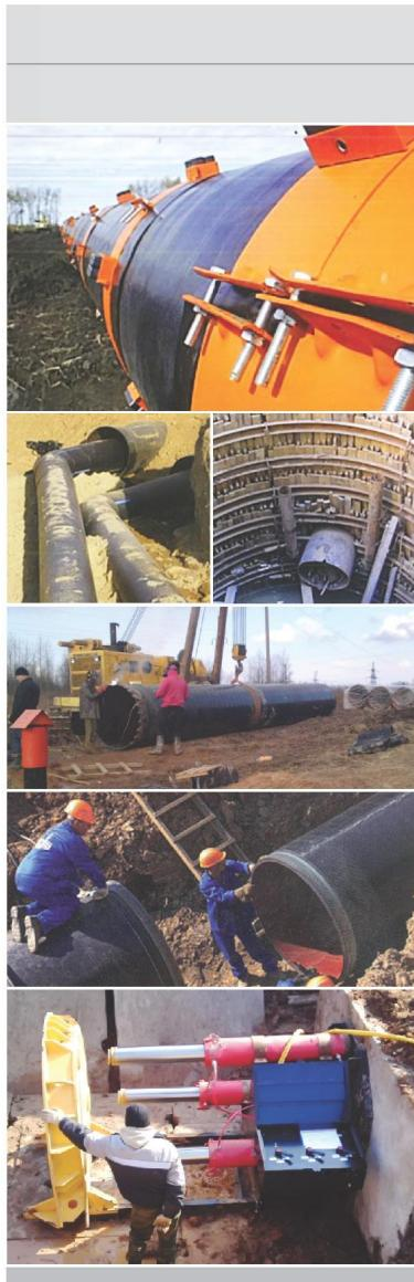
Установки для бестраншевой прокладки коммуникаций оснащены гидравлическим приводом высокого давления, что позволило создать серию высокопроизводительного, мобильного и простого в эксплуатации оборудования.
